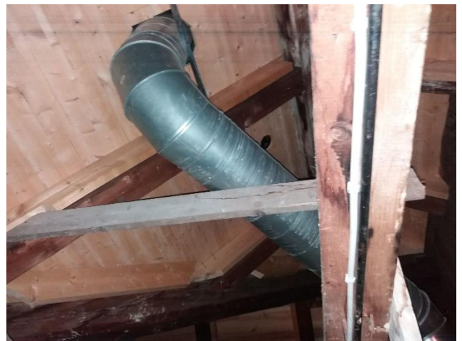
Større uisoleret aftrækskanal
