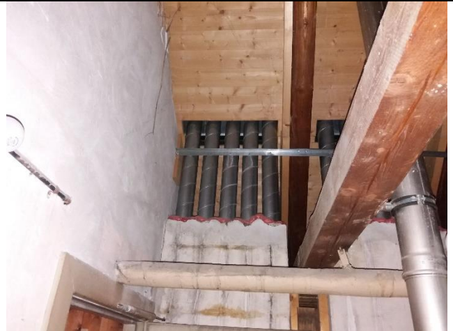
Uisoleret aftrækskanaler
