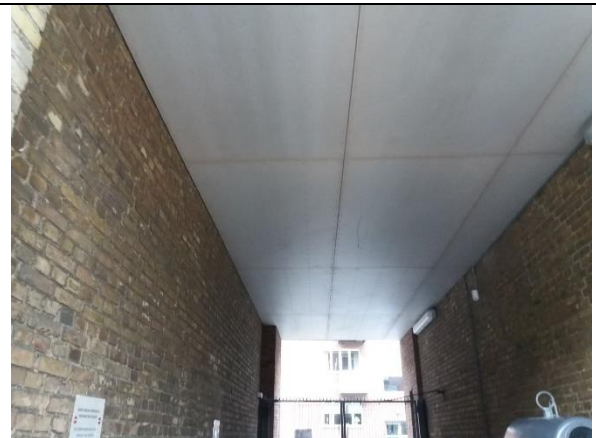
Port med efterisoleret loft
