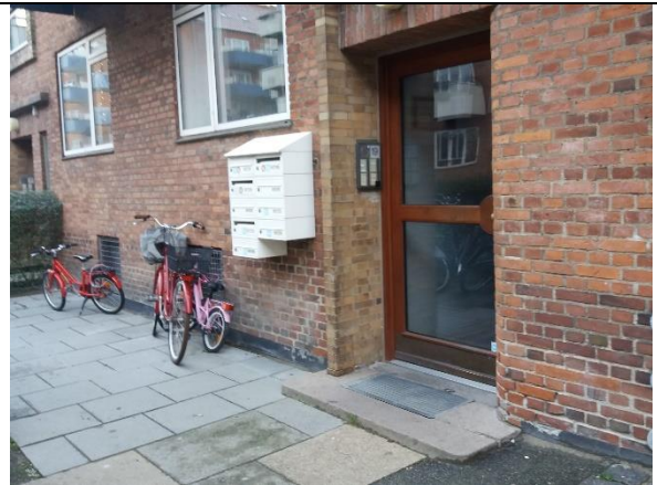
Opgangsdør mod Maltagade
