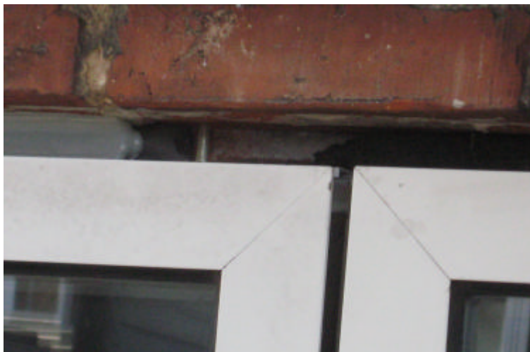
Stålprofil over vinduer til beboelse.
